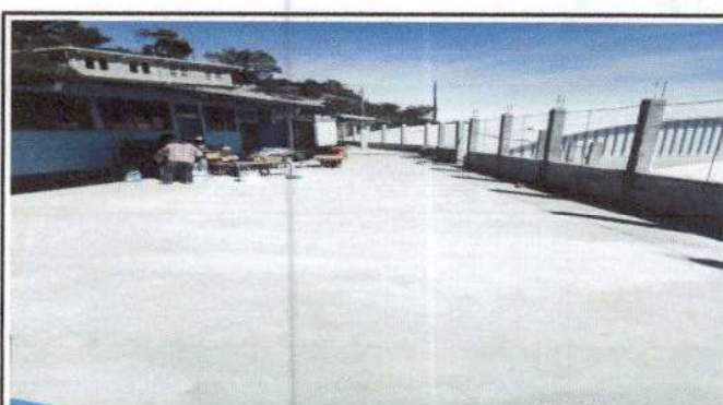
Foto 4: SUSTITUCIÓN DE PISO DE TIERRA POR TORTA DE CONCRETO DE PATIO
