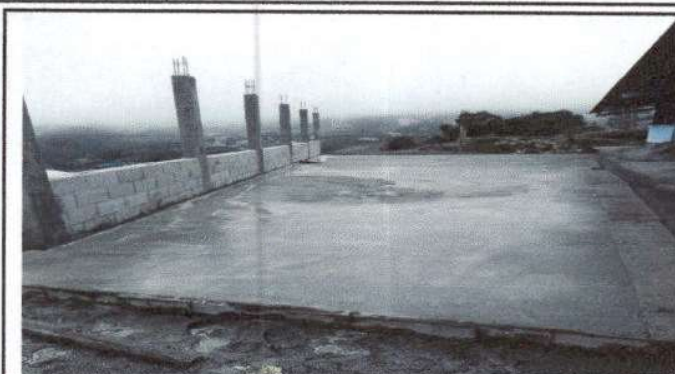
Foto 2: REPARACION DE MURO PERIMETRAL 14 METROS
