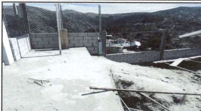
Foto1: REPARACION DE MURO PERIMETRAL 14 METROS
