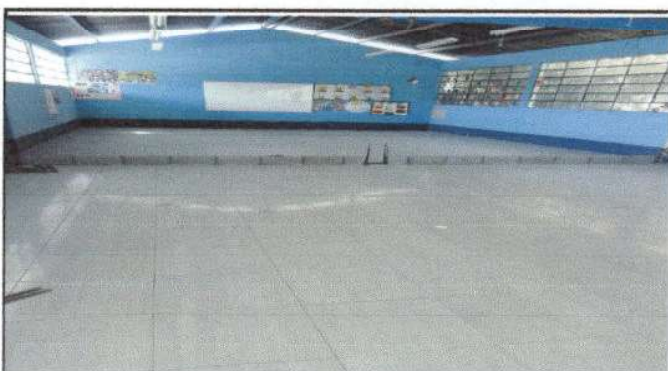
Foto 3: SUSTITUCIÓN DE PISO DE CONCRETO POR PISO CERAMICO
