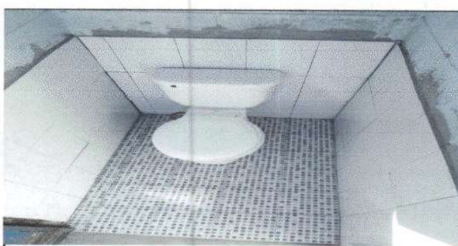
Foto 6: SUSTITUCIÓN DE INODORO
